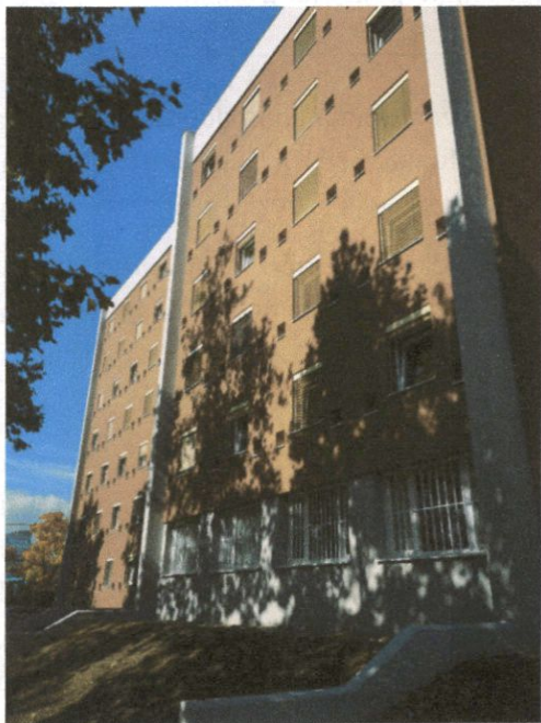
Obnova fasade (D)
