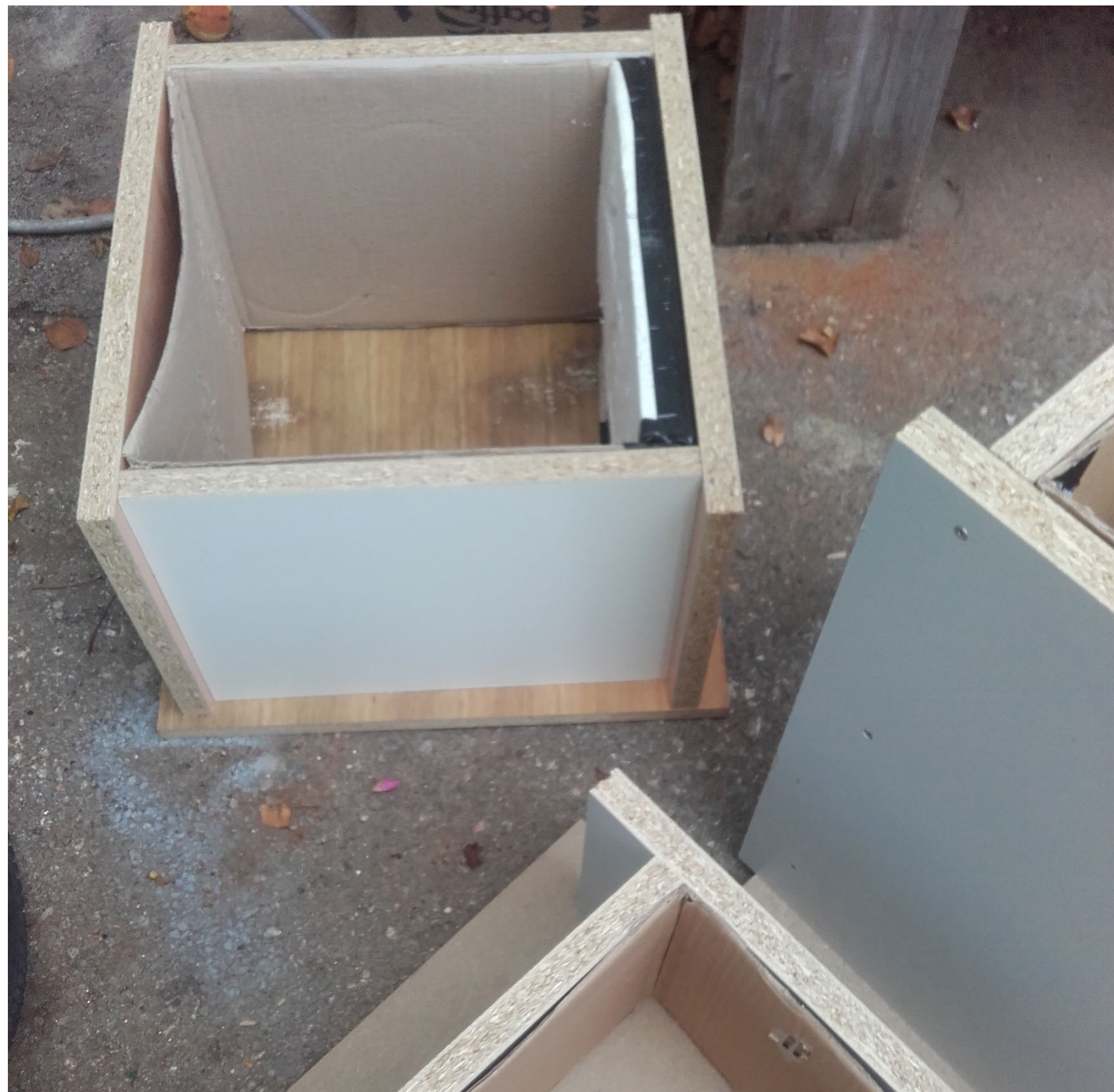
Slika 8: Izdelava opažev za kalupe. (foto: Doroteja Erhatic, 2018)
