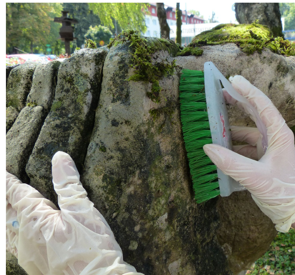
Slika 22: Odstranjevanje mahov s krtačo (foto: Ana Sterle, osebni arhiv, 22. 8. 2018)
