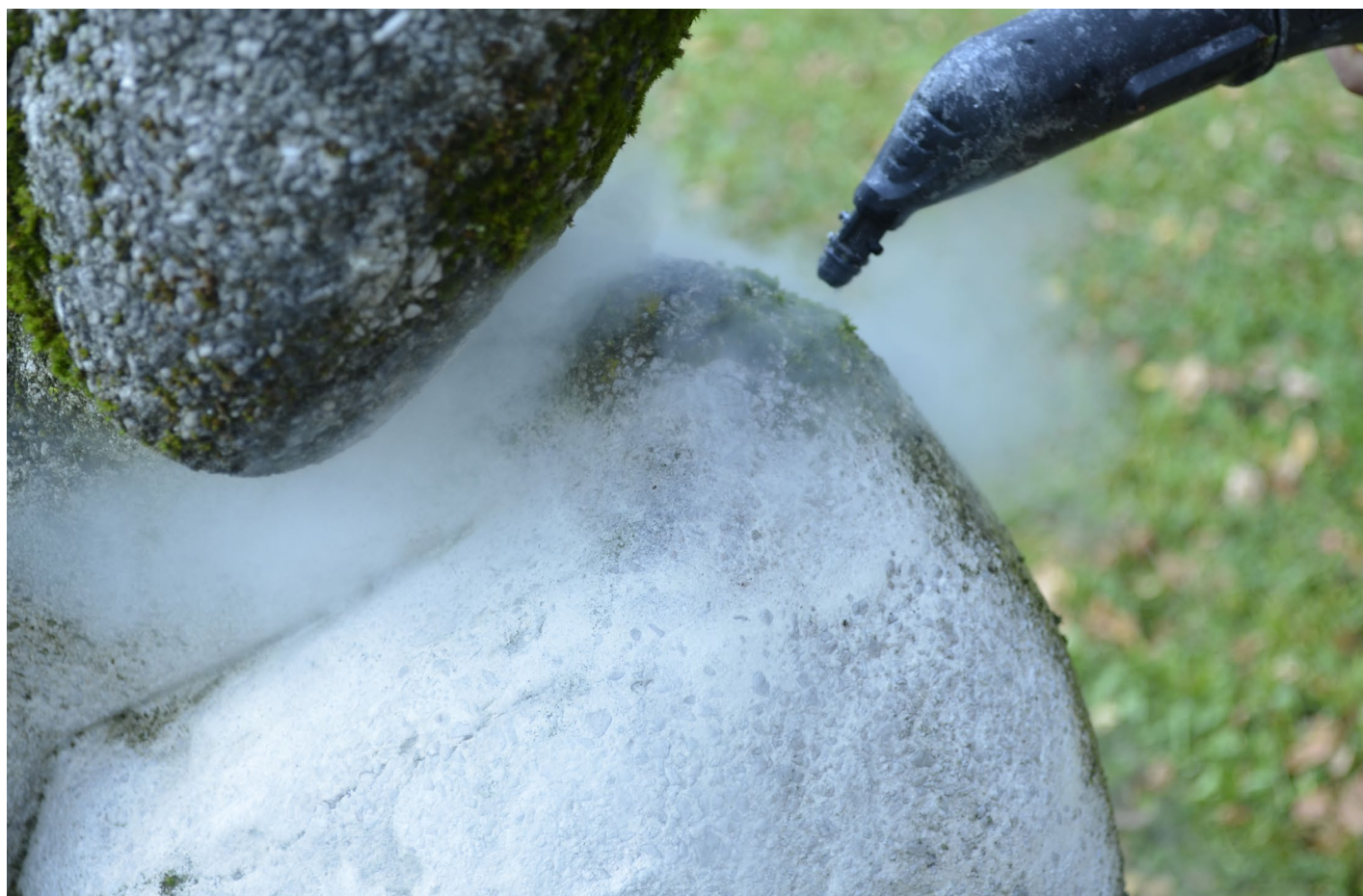
Slika 23: Čiščenje s parnim čistilnikom (foto: Ana Sterle, osebni arhiv, 22. 8. 2018)
