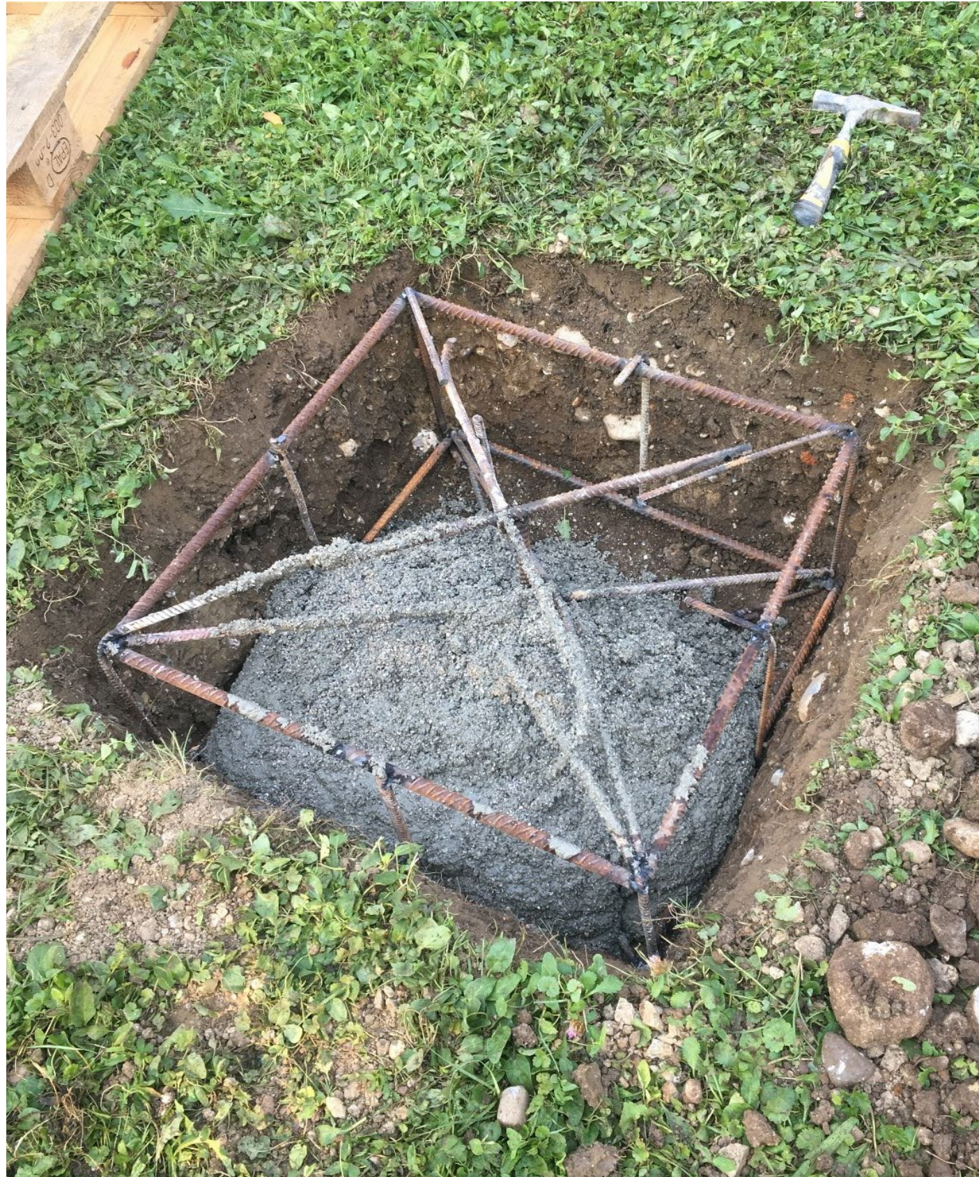
Slika 2: Betoniranje armature v luknjo (vir: Maja Bojanić, 2018)
