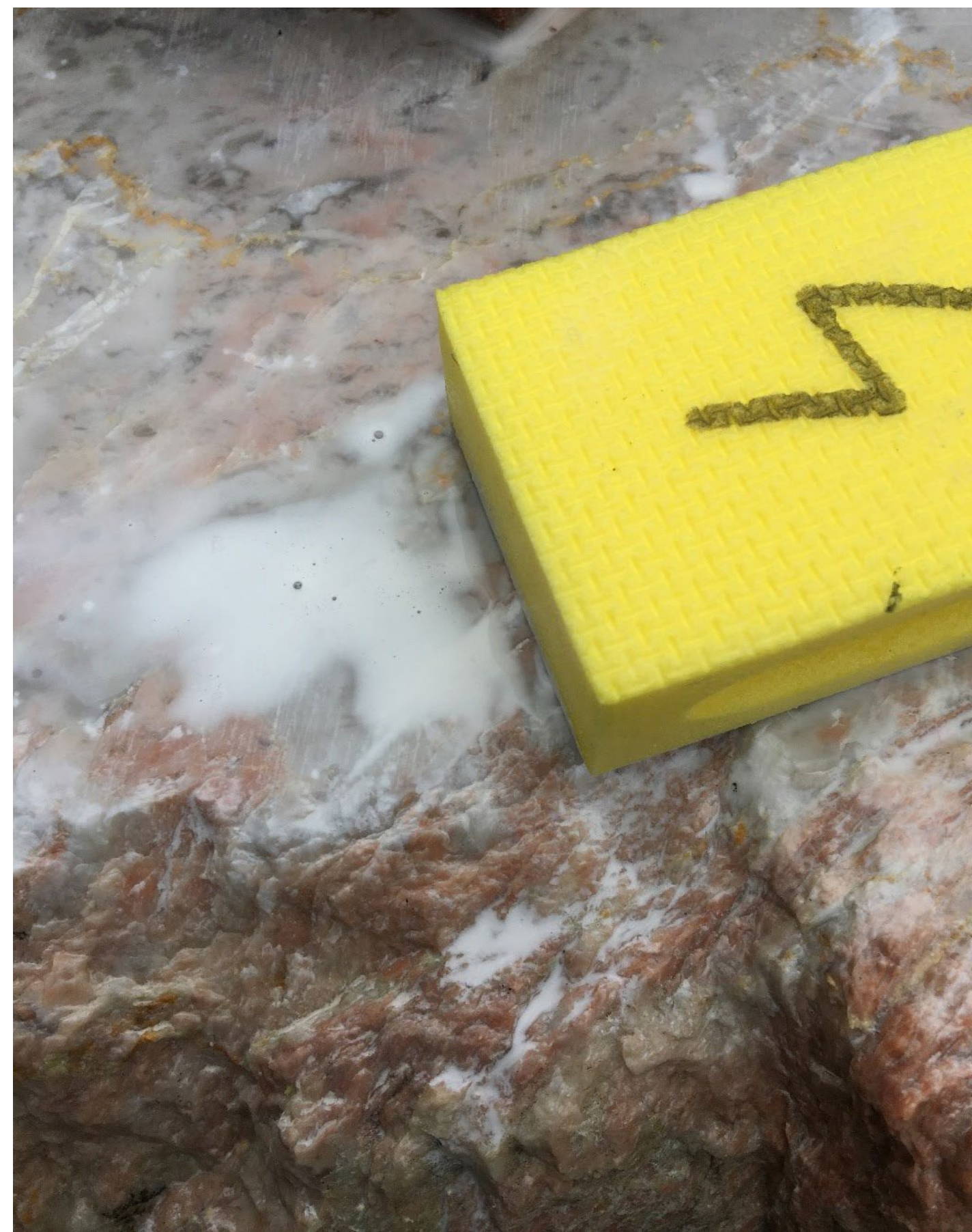
Slika 5: Detajl poliranja površine z diamantno gobico (foto: Maja Bojanić, 2018)
