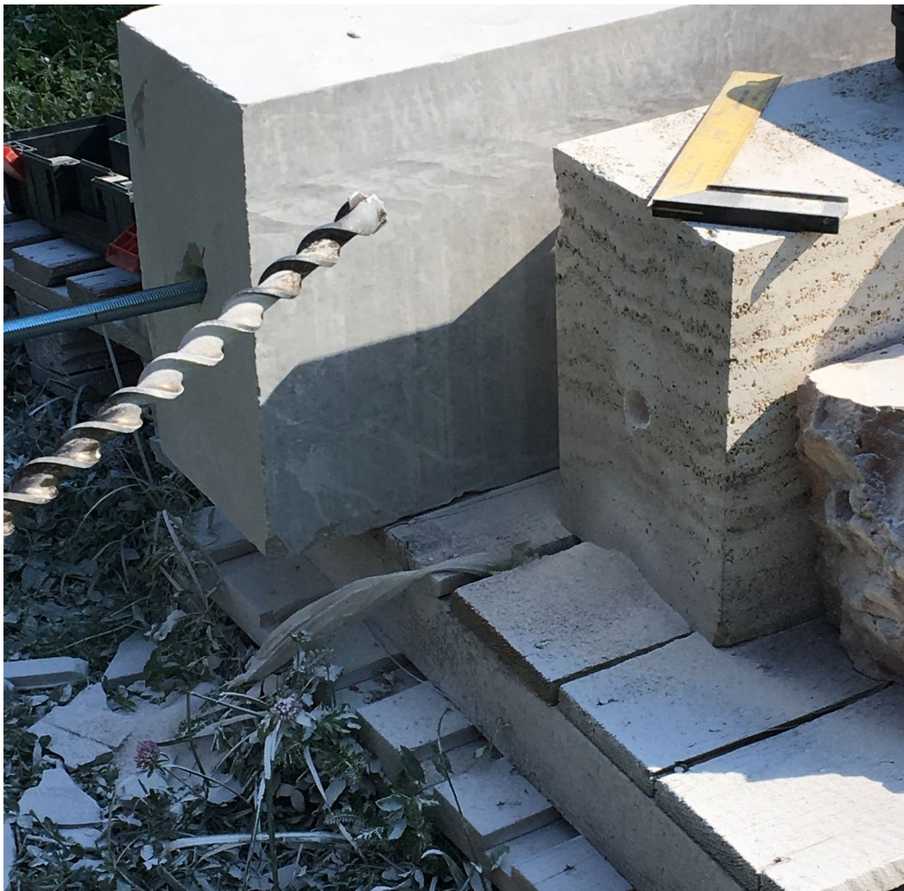
Slika 3: Vstavljanje navojne palice v kamen (foto: Maja Bojanić, 2018)
