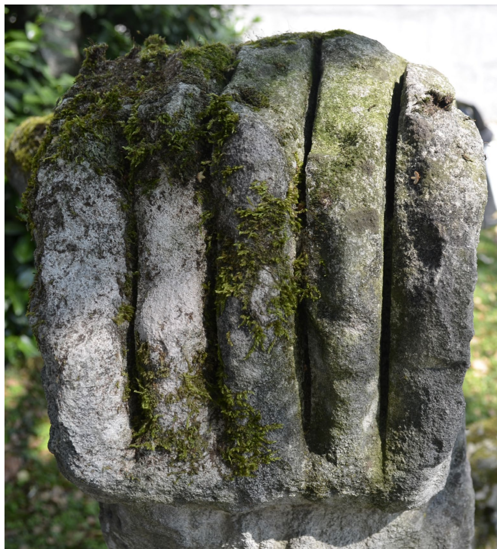
Slika 21: Rezultat delnega odstranjevanja mahov z leseno modelirko (foto: Ana Sterle, osebni arhiv, 22. 8. 2018)
